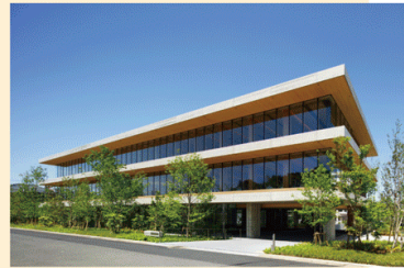
新柏クリニック(千葉県) 平成28(2016)年 ※1 (写真提供: エスエス 島尾 望)
