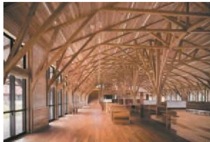
屋久島町庁舎(鹿児島県)※1 ※2 令和元(2019)年
