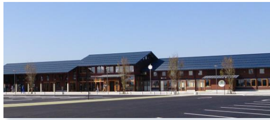
道の駅あいづ(福島県 湯川村)
