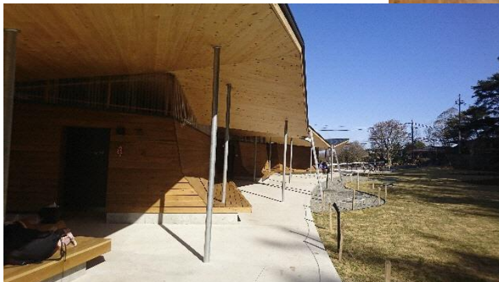
六甲最高峰トイレ（兵庫県 神戸市）
