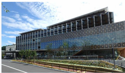
小林市新庁舎(宮崎県 小林市)
