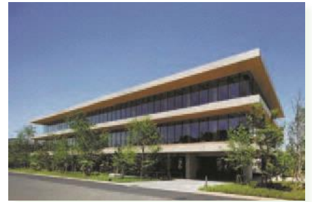
新柏クリニック(千葉県)※1 平成 28(2016)年 (写真提供:エスエス 島尾 望)
