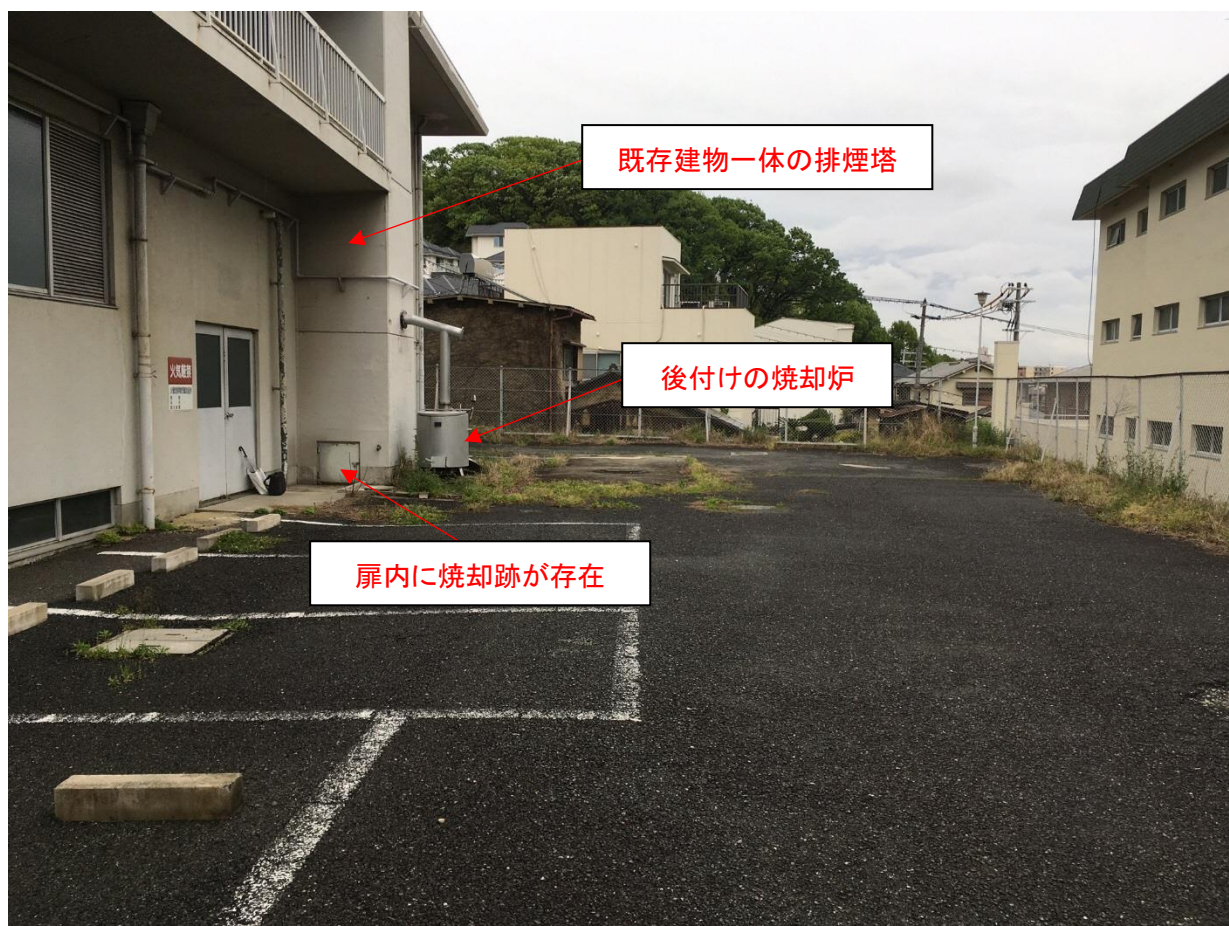
図2 既存建物一体の排煙塔及びその排煙塔に接続した焼却炉の状況
