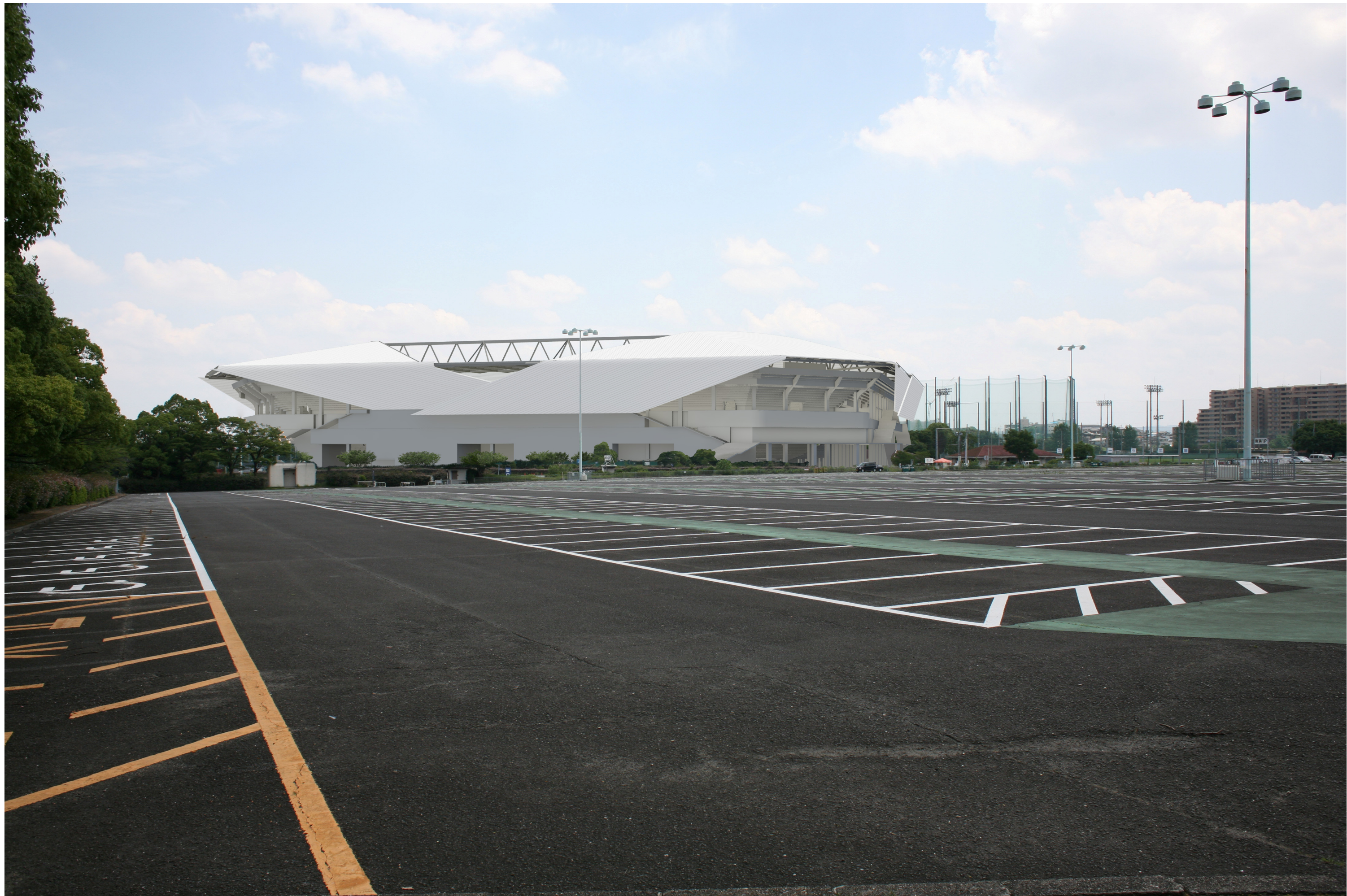
南駐車場 施設完成後
