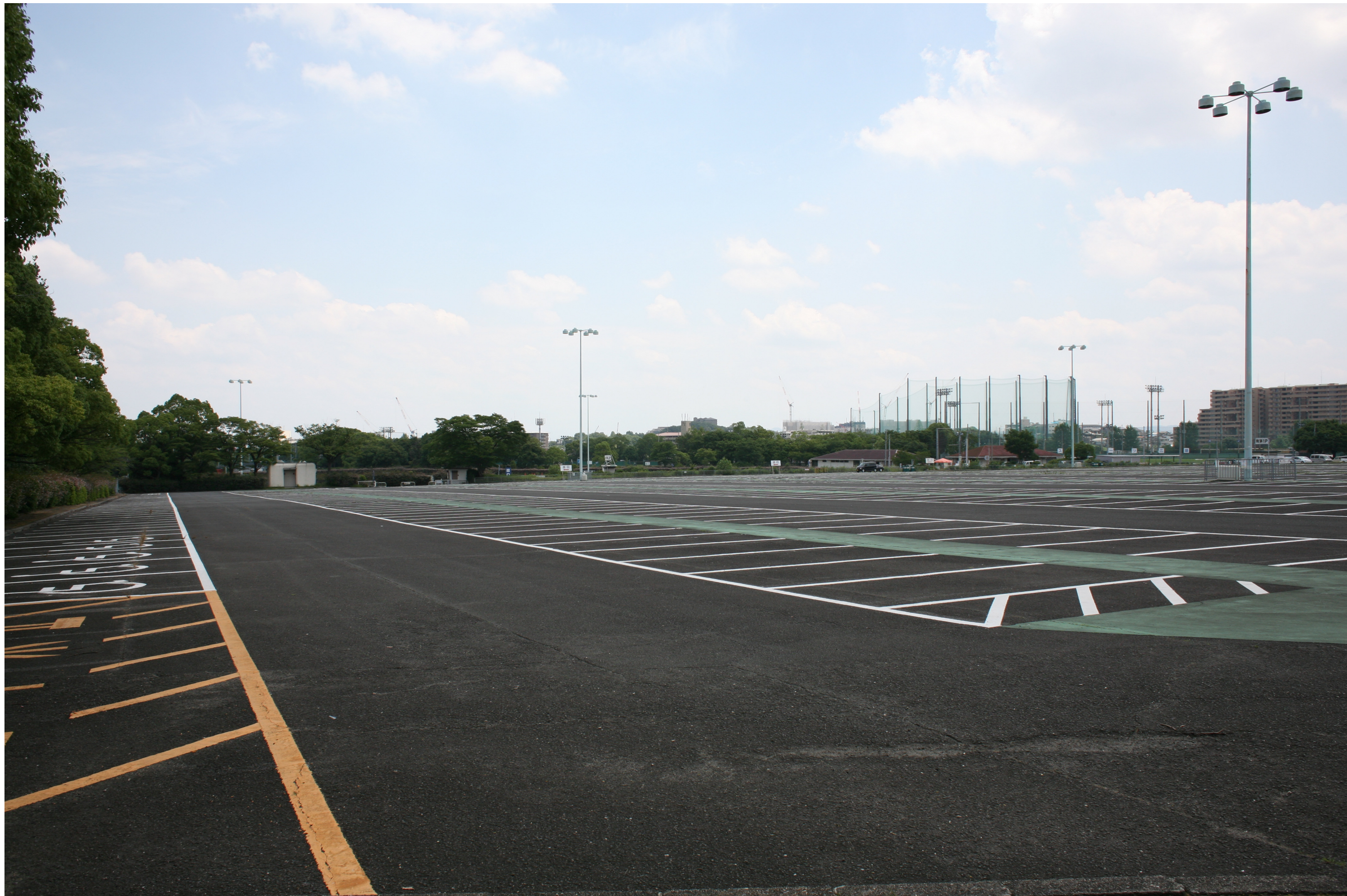
南駐車場 現況
