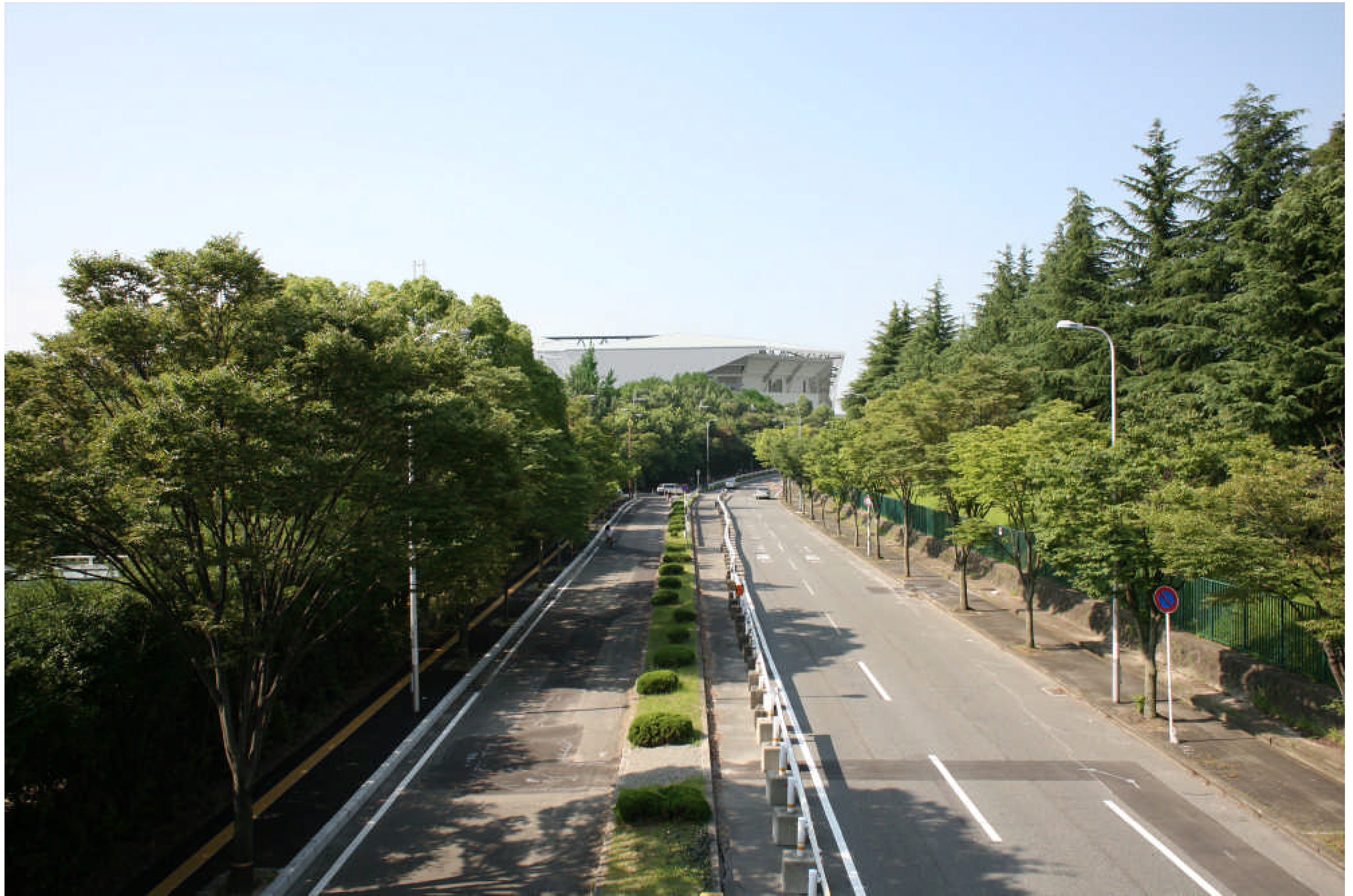
平成調和歩道橋 施設完成後
