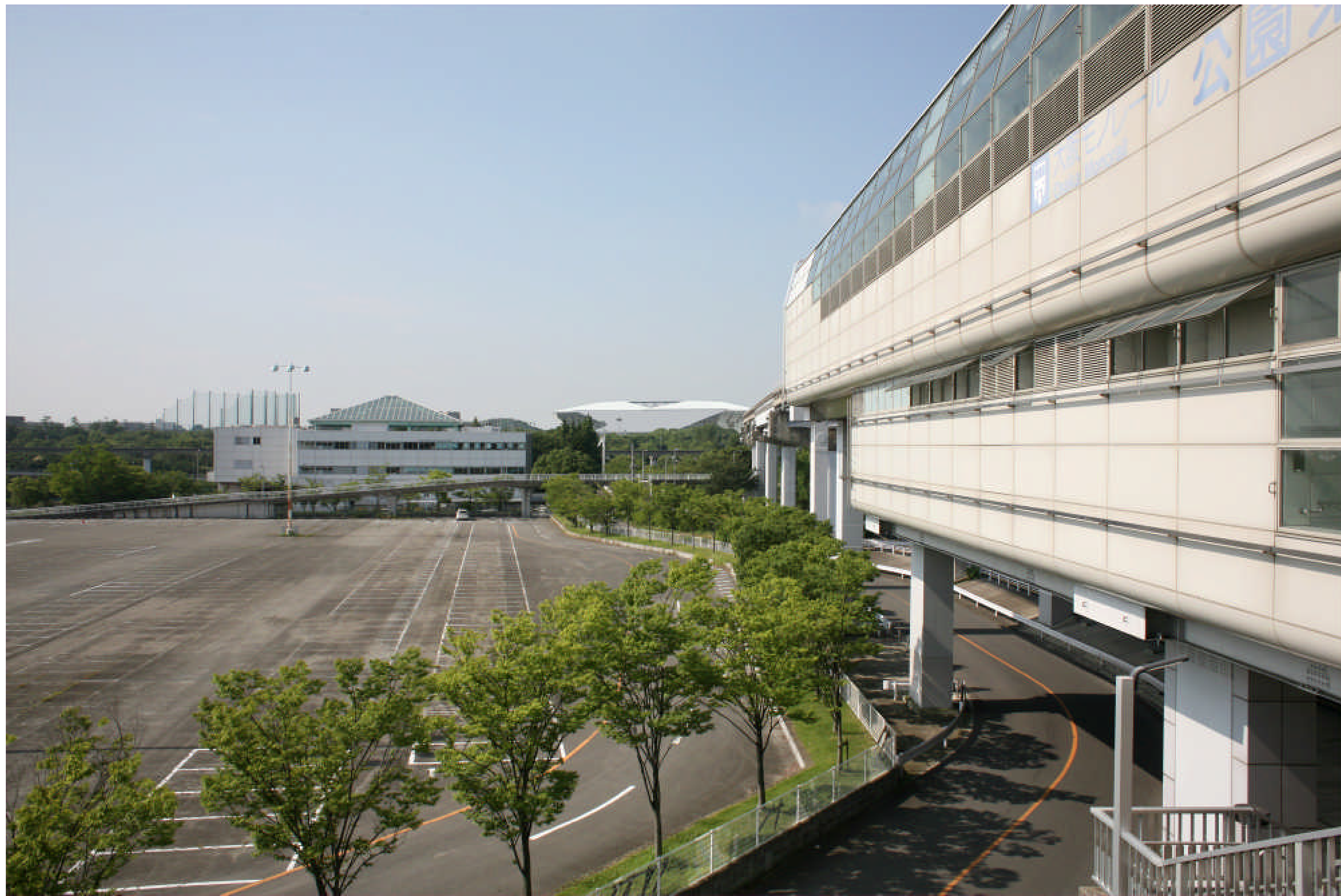
公園東口駅前 施設完成後
