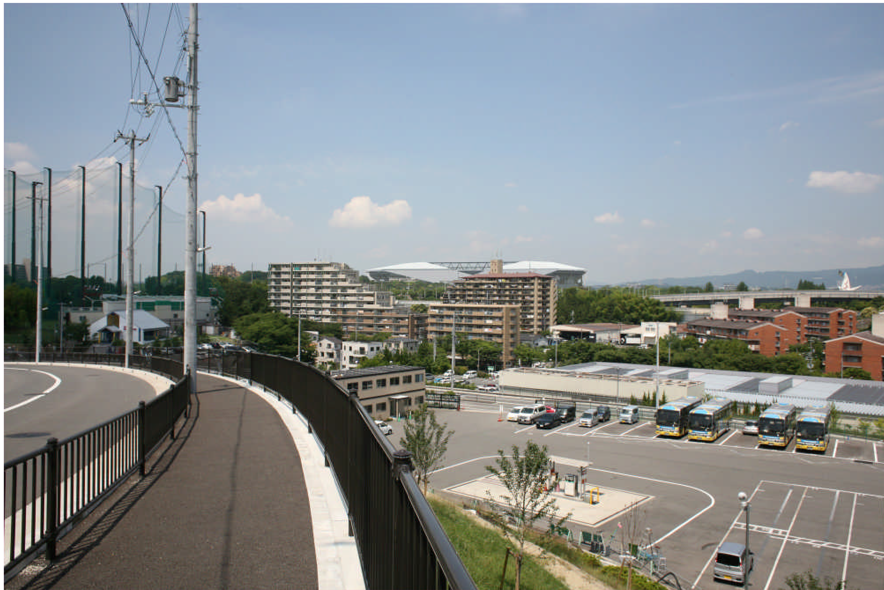
千里丘北 施設完成後
