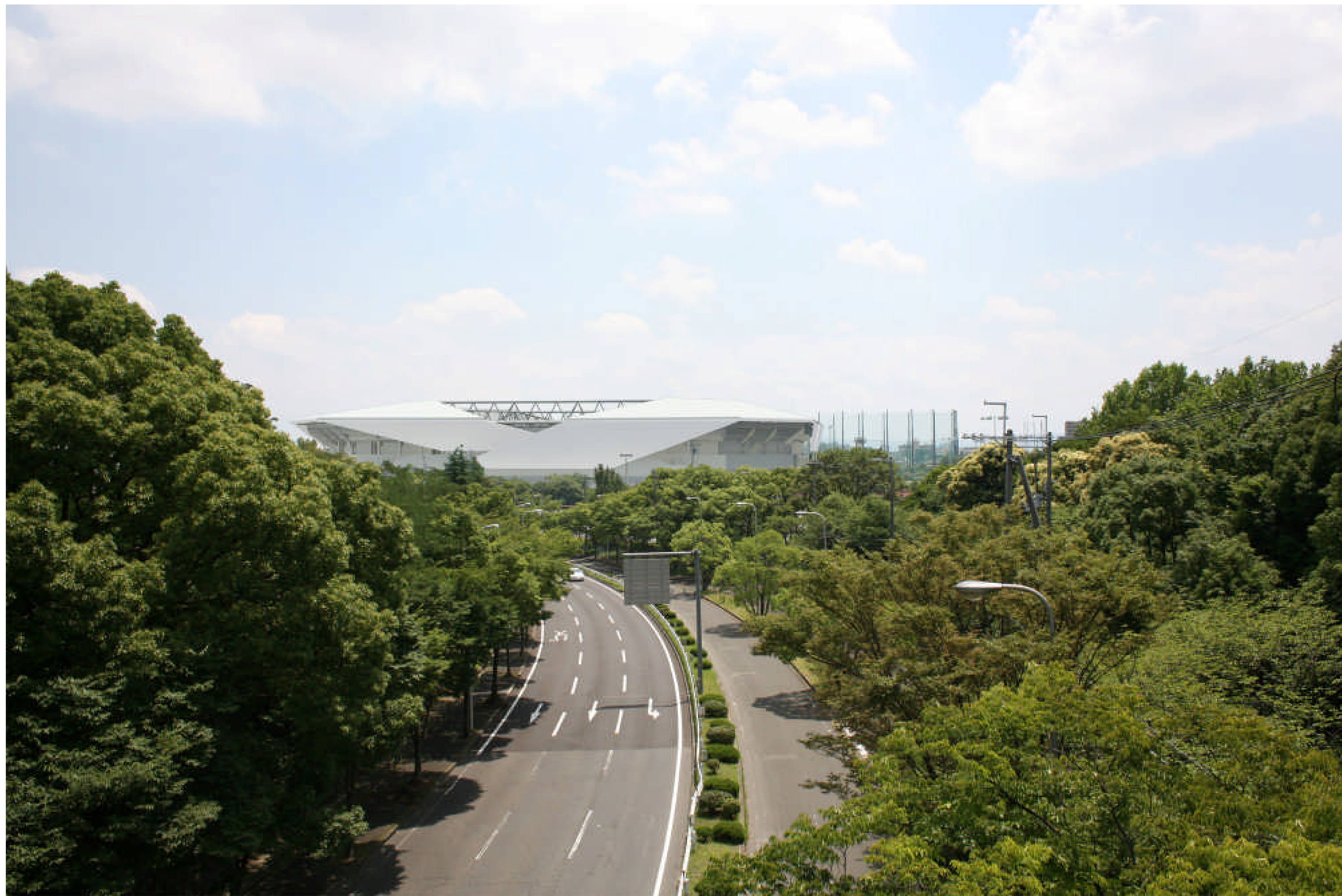
万博南歩道橋 施設完成後
