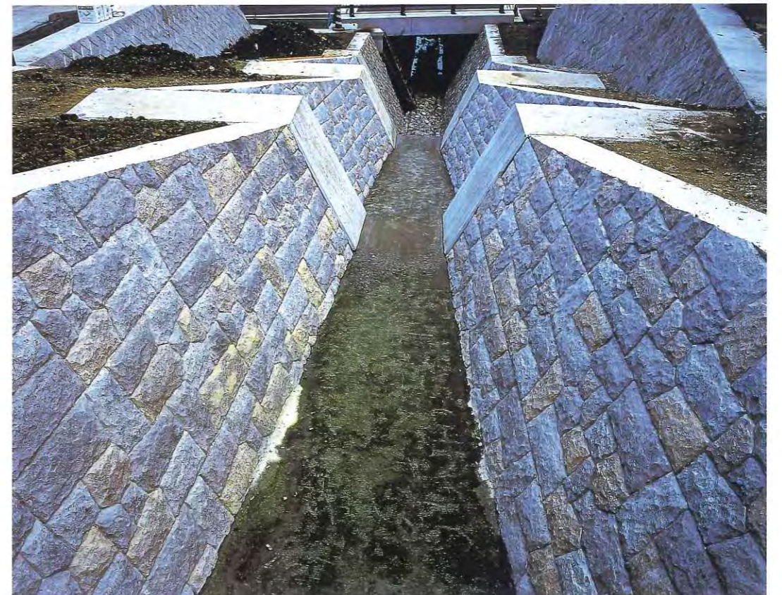
南沢川砂防ダム
