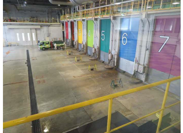
プラットホーム（回収車で市内のごみを回収）
