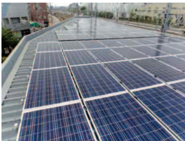
(写真：JR吹田駅前西自転車駐車場の屋根の様子)
