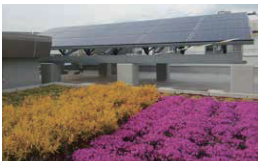
屋上の太陽光パネルと植栽
