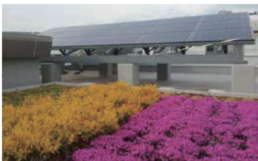
屋上の太陽光パネルと植栽
