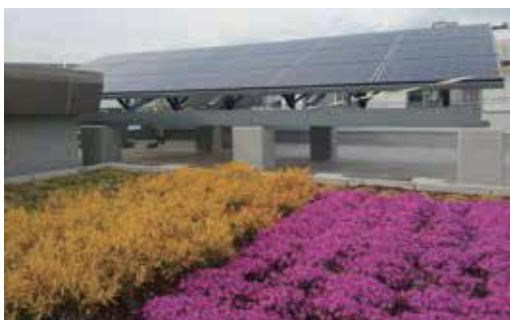
屋上の太陽光パネルと植栽
