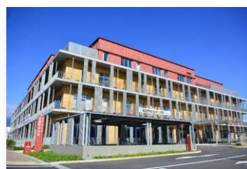
安曇野市庁舎（長野県 安曇野市）
