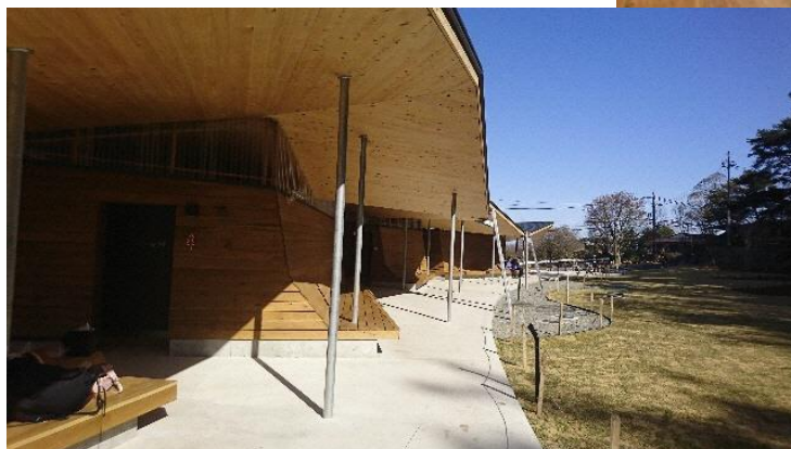
六甲最高峰トイレ（兵庫県 神戸市）
