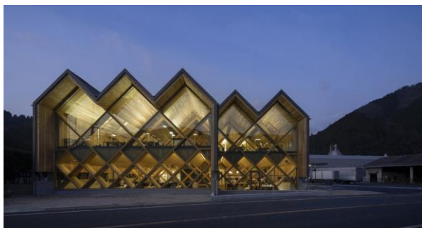
銘建工業本社事務所(岡山県 真庭市)
