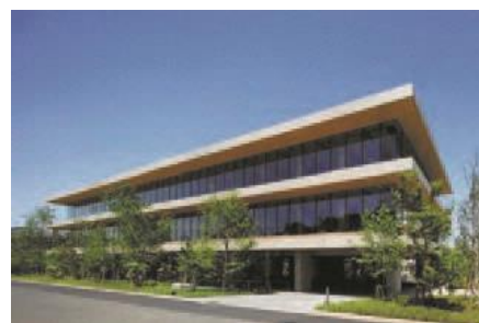
新柏クリニック(千葉県)※1 平成 28(2016)年 (写真提供: エスエス 島尾 望)
