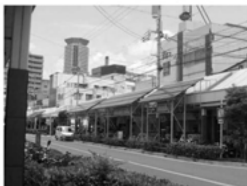
（旭通商店街に設置した太陽光パネルの一部）
