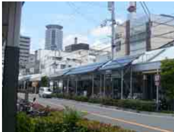
(旭通商店街に設置した太陽光パネルの一部)
