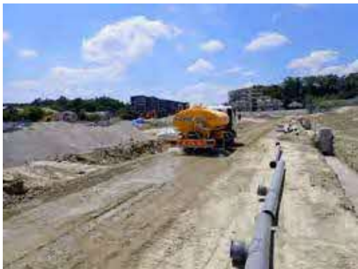
7 散水作業状況
