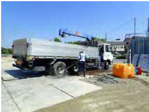
3 退出車両洗浄状況
