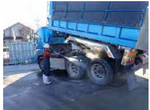
4 退出車両洗浄状況
