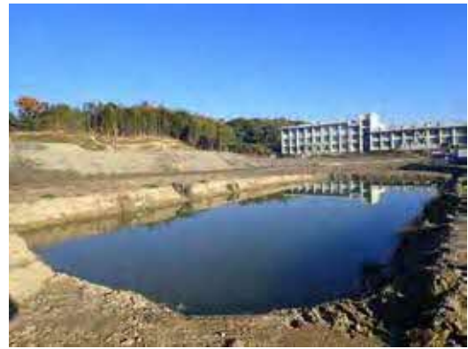
10 沈砂池設置状況
