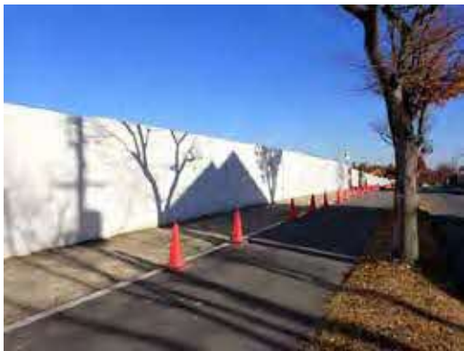
5 万能板設置状況
