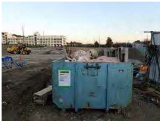
11 一般廃棄物保管状況
