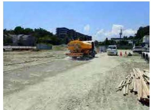
8 散水作業状況
