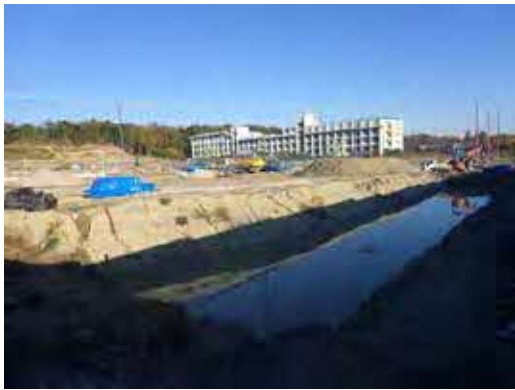
9 沈砂池設置状況
