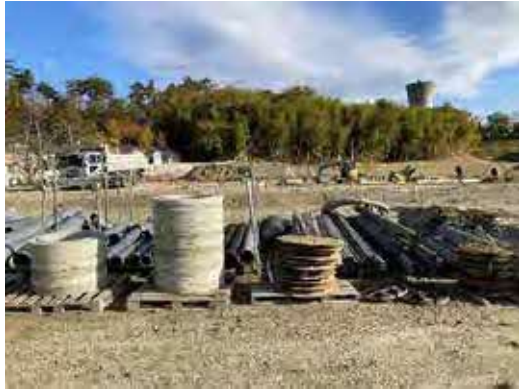
6 資材置き場の状況
