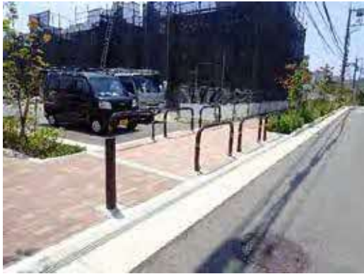
9 バリカー設置状況
