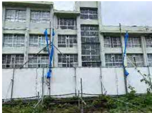
4 防音シート設置状況
