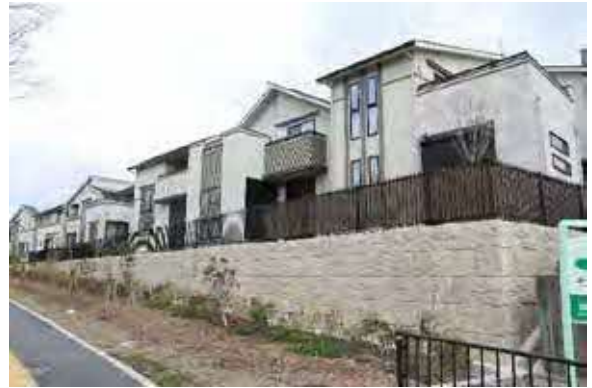
10 千里けやき通り沿いの擁壁の状況
