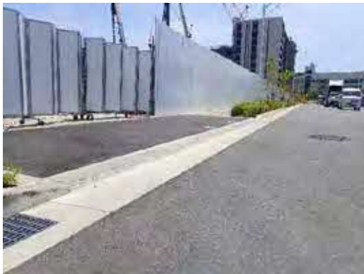
3 万能板設置状況
