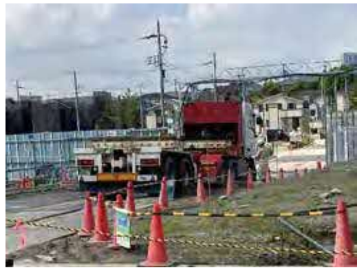
2 退出車両洗浄状況
