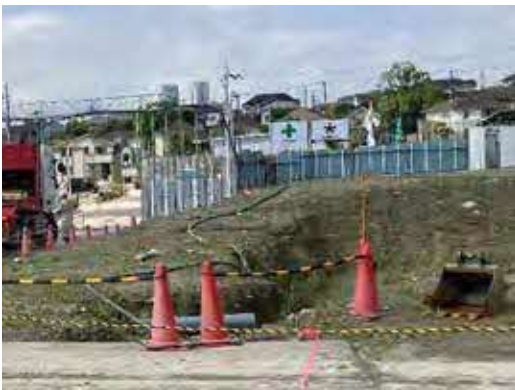
5 沈砂池設置状況
