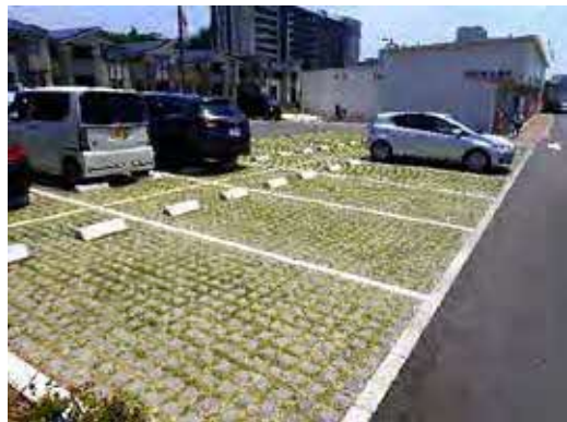
8 緑化ブロック設置状況
