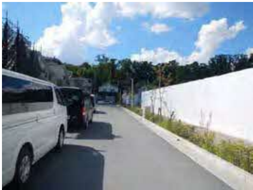
3 万能板設置状況
