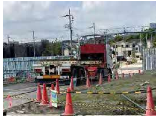
2 退出車両洗浄状況
