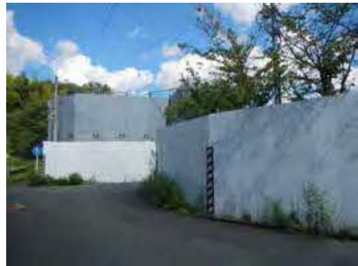
4 万能板、防音シート設置状況
