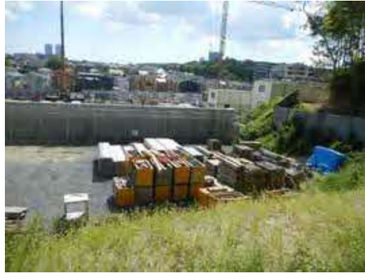
6 資材置き場の状況
