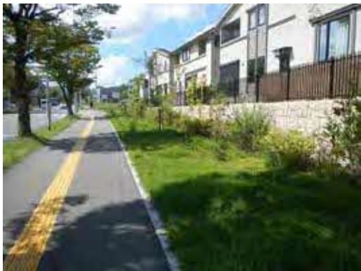
7 下水道敷での緑化状況
