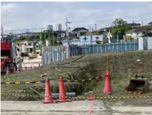
5 沈砂池設置状況
