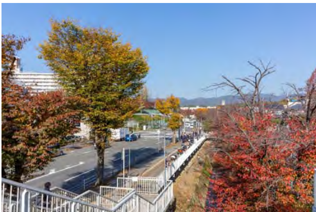
【北千里駅陸橋】
