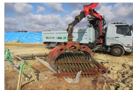
スクラップ'仮置 積込み状況
