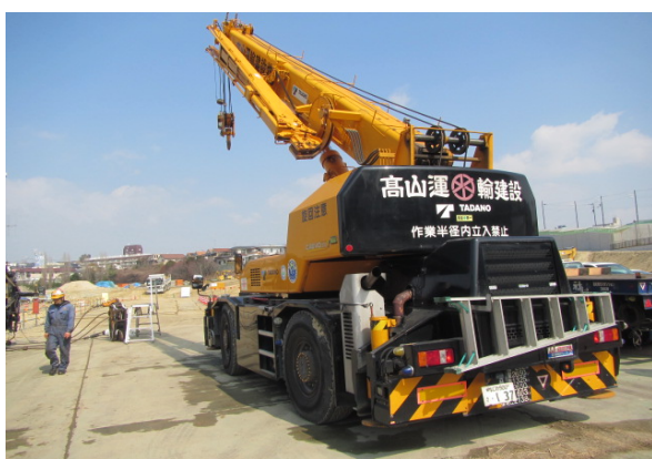
ラフタークレーン(移動式クレーン、25tクラス)
