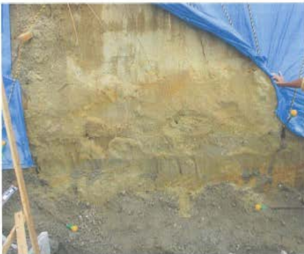
第4図 道路法面に見られる地層（右が真西）
