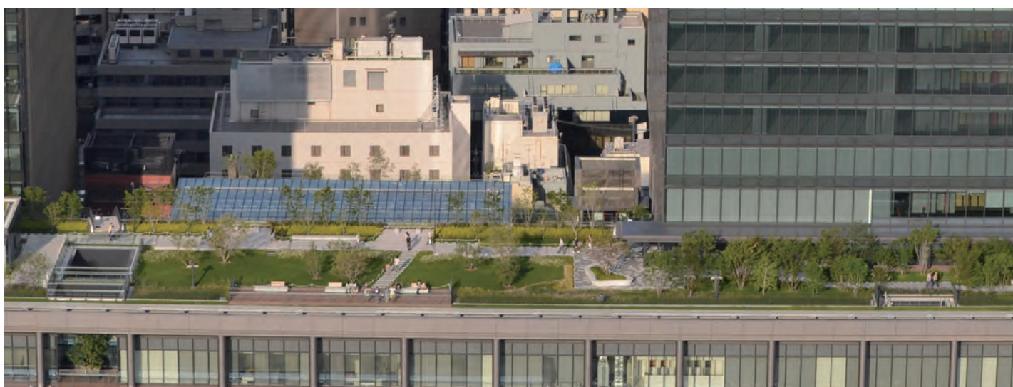
●屋上緑化(グランフロント大阪)
