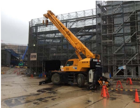
ラフタークレーン (25 t 級)
