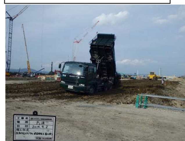
スタジアム残土受入状況
