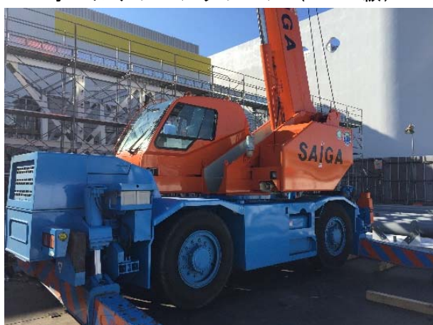
ラフタークレーン (16 t 級)
