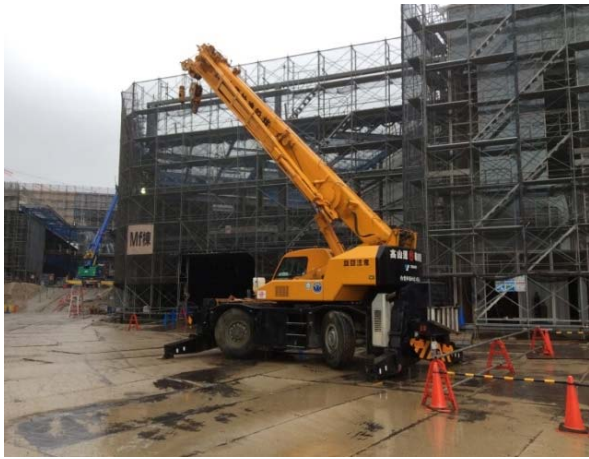
ラフタークレーン (25 t 級)
