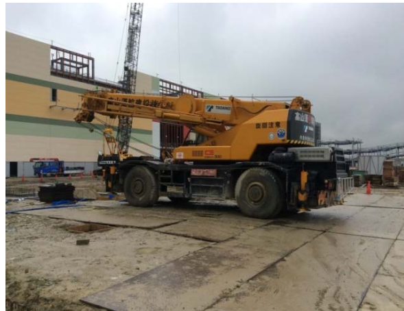
ラフタークレーン (50 t 級)
