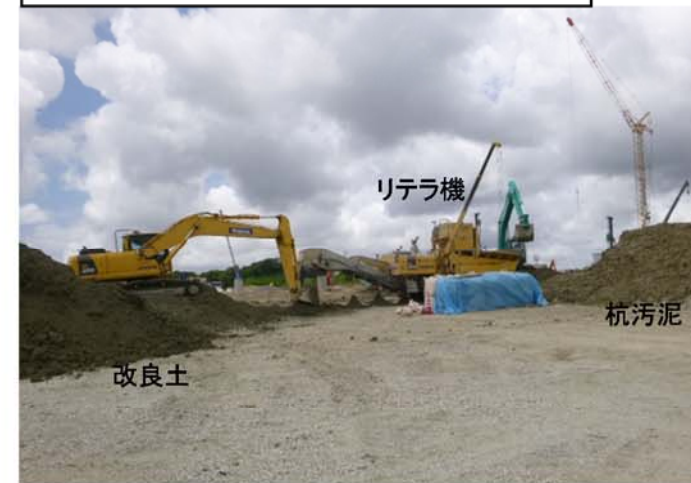
④ 杭汚泥の再資源化利用状況
