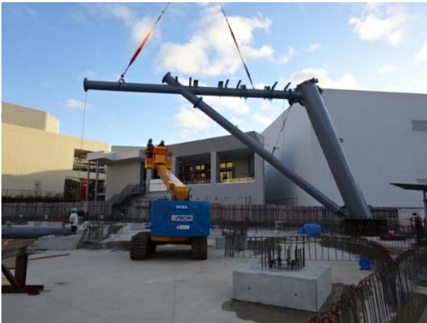
高所作業車（21m級）
