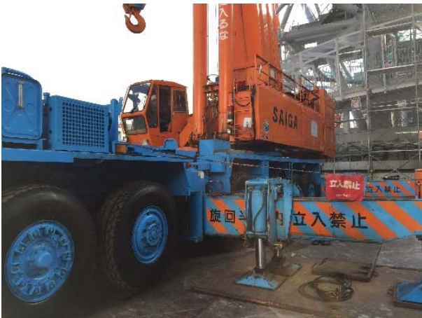
ラフタークレーン (360 t 級)
