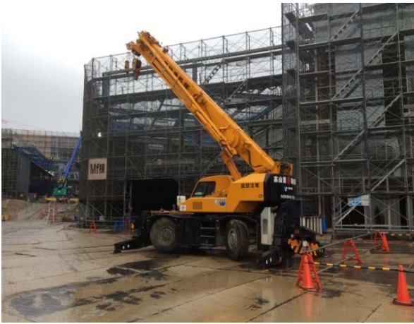
ラフタークレーン (25 t 級)
