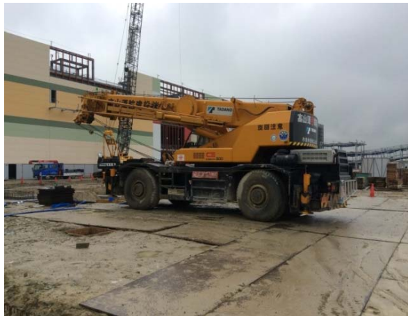
ラフタークレーン (50 t 級)
