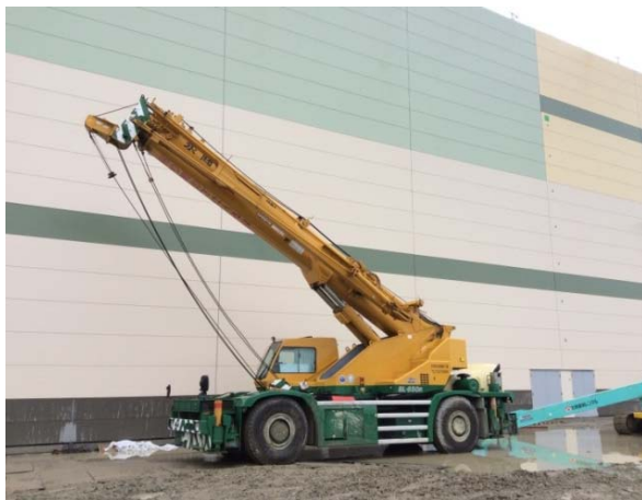
ラフタークレーン (70 t 級)
