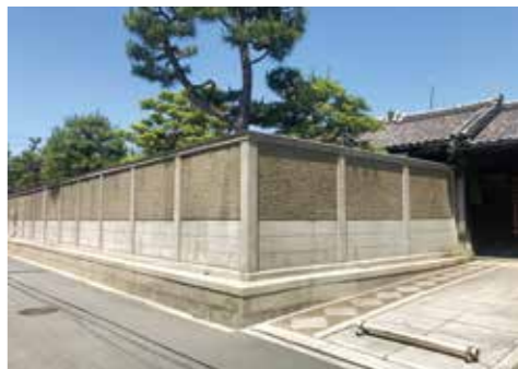
今年5月に工事が完了した外塀
