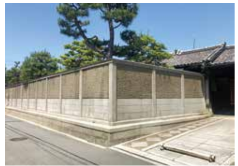
今年5月に工事が完了した外塀
