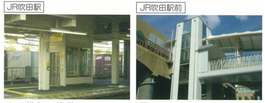
○ 駅構内及び郊外のエレベーター設置
