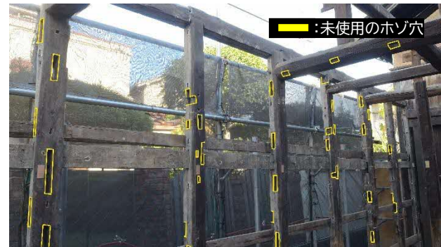
45 納屋(米蔵北) 軸組解体中 東面 納屋(米蔵北)の柱には現在は使われていないホゾ穴がたくさんありました。通常は各ホゾ穴に対応する部材がかつて存在していたと推定するところですが、この建物にこれほど多くの部材があったとは考えにくく、この場合は別の建物の柱を転用したためであると見られます。
