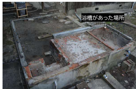
39 浴室棟 浴室部分解体中 浴室部分は煉瓦で造られていました。西尾家では床・壁などに煉瓦が多く使用されています。
