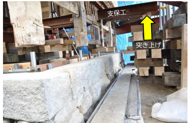
25 参考ジャッキアップ状況 ある別の現場で建物をジャッキアップしたときの写真です。このように鉄骨などで組んだ支保工を下から突き上げて建物を持ち上げ、足元の部材が修理可能な状況を作り出します。
