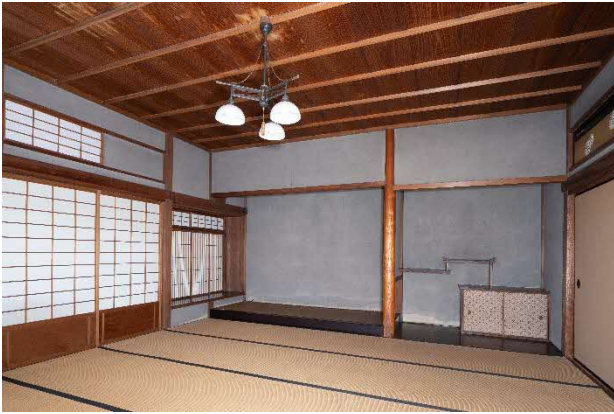
8 修理前 主屋内部 座敷
