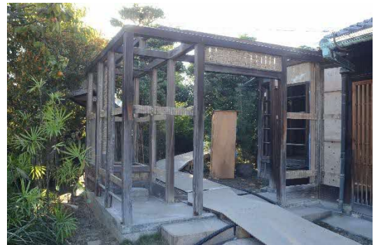
29 露地門雪隠 軸部解体中 順を追って建物を「解体」している最中の写真で、建物を軸組材だけの状態にしたところです。この状態で解体を止めると「半解体」と言います。
