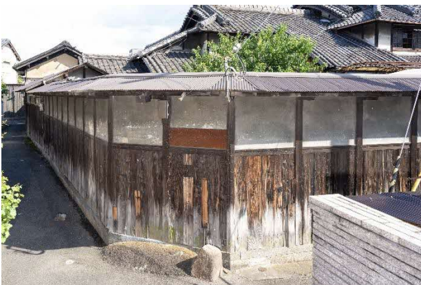
22 修理前 納屋(北東) 道路側
