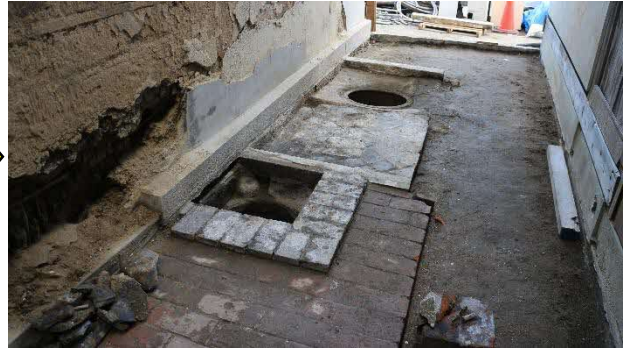
55 主屋-米蔵間通路 モルタル解体 モルタル塗りを解体すると、便所の跡が現れました。これはまったく予想外の発見でした。
