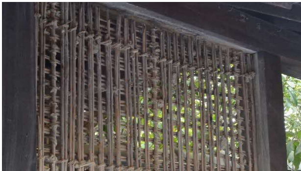
28 露地門・雪隠 壁解体中 土壁の下地(小舞と言います)には竹を用いるのが一般的ですが、西尾家では葦が多く使用されていました。
