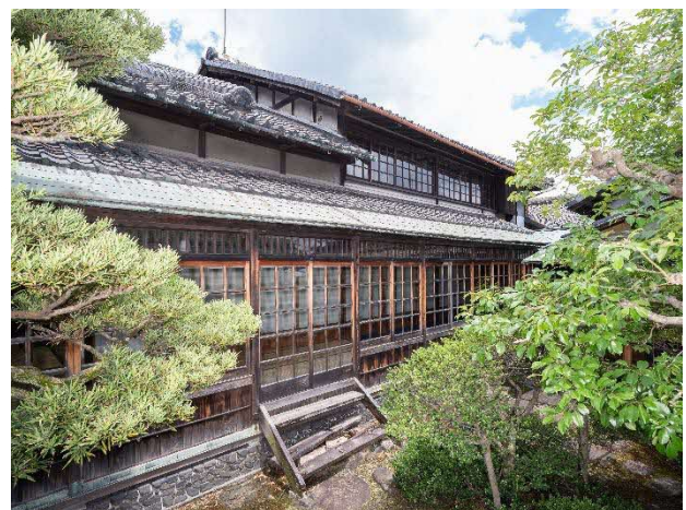
5 修理前 主屋南面(居住部)
