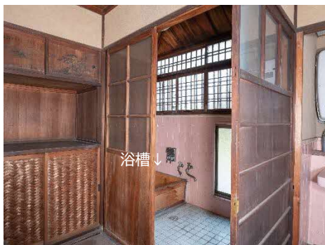
38 浴室棟 修理前 浴室部分
