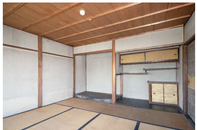
13 修理前 主屋内部 二階表八畳
