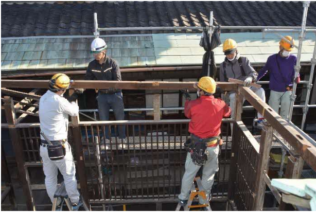
24 主屋 浴室棟 解体工事中 主屋の浴室棟は「解体修理」としました。
