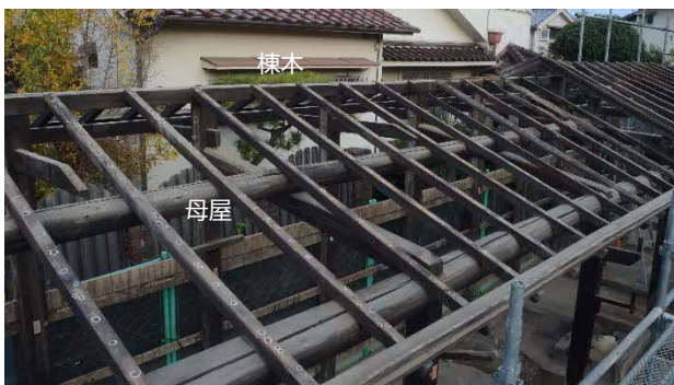
46 納屋(北東) 屋根解体中 西流れ 納屋(北東)の屋根は大半の部分でこの写真に見えるような形式であり、道路寄りに棟木を設け、一本材の垂木を架けていました。
