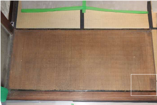
56 主屋 居間の畳 修理前は箆笥の下に隠れていましたが、おそらく当初と思われる古い畳表が残っていました。
