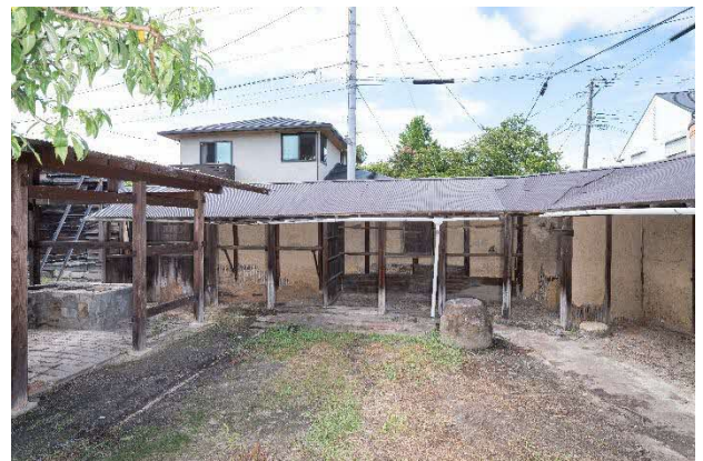
21 修理前 納屋(北東) 敷地側
