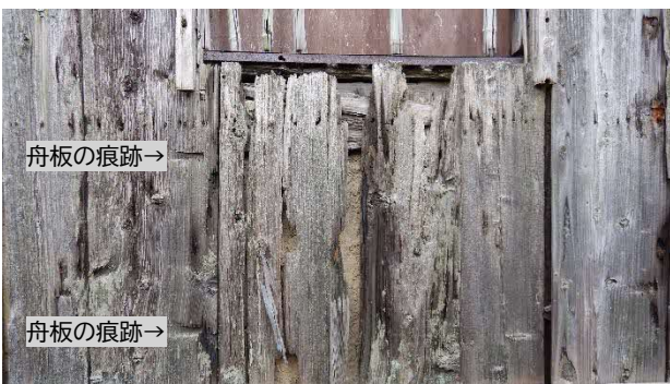
51 外塀(旧蔵納屋外壁) 壁板解体 柿渋塗装中 外塀の壁板には舟板が用いられており、特徴的な意匠と考え、破損がかなり進行していましたが、なるべく材料を再用できるよう慎重に解体しました。
