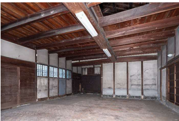
14 修理前 主屋内部 計量部屋
