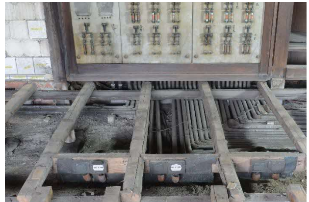
59 台所の配電盤 西尾家の台所には、たいへん立派な旧式の配電盤が現存していましたが、その場所の床を解体したところ、多量の古い配管が現れました。
