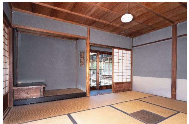
11 修理前 主屋内部 味々庵
