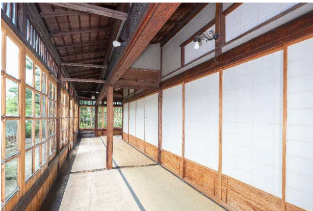
10 修理前 主屋内部 縁座敷
