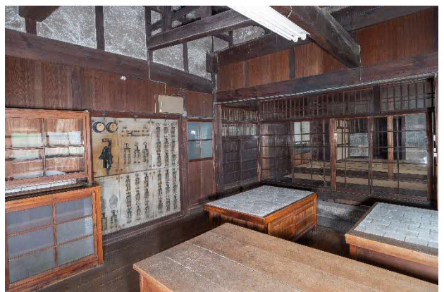
15 修理前 主屋内部 台所
