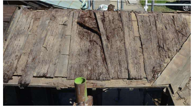
27 露地門・雪隠 屋根解体中 屋根の下地には杉皮が用いられていました。
