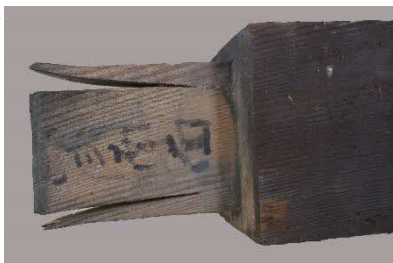
53 各部材記録写真 柱墨書 解体した部材は個別で記録写真を撮影し、実測を行います。また墨書が見つかることもあります。写真は雪隠の柱で、頂部のほぞに「い式南面」という墨書がありました。これは建設時に、柱を建てる位置を記したもので、「番付」といいます。各柱から見つかった墨書を整理すると右の図のようになり、建設時にどのように番付していたのかを推測することができました。
