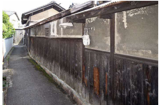
19 修理前 納屋(米蔵北)・納屋(北東) 道路側
