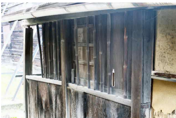
46 納屋(北東) 屋根解体中 西流れ 納屋(北東)の屋根は大半の部分でこの写真に見えるような形式であり、道路寄りに棟木を設け、一本材の垂木を架けていました。
