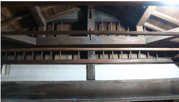
40 女部屋 修理前 部屋境小壁上部(東から見る) 女部屋の室内の小壁の上部に鉄格子が嵌められていました。現在、部屋境になっている壁が、当初は外部に面しており、鉄格子は換気(煙出し)のために設けられていたと考えられます。
