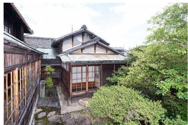
7 修理前 主屋西面(玄関部)
