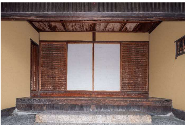
12 修理前 主屋内部 式台玄関
