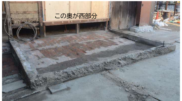
41 女部屋 東部分解体完了 女部屋の東部分の解体が完了したところです。(写真のベニヤ板の奥が西部分になります。) 東部分の床下は煉瓦敷となっていました。
