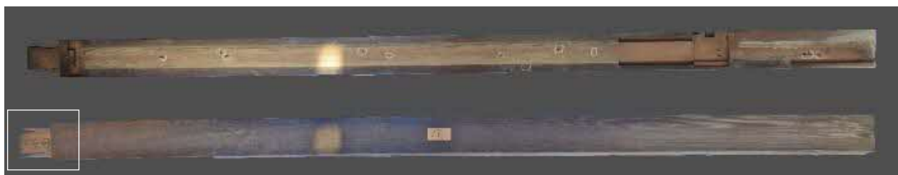
51 外塀(旧蔵納屋外壁) 壁板解体 柿渋塗装中 外塀の壁板には舟板が用いられており、特徴的な意匠と考え、破損がかなり進行していましたが、なるべく材料を再用できるよう慎重に解体しました。
