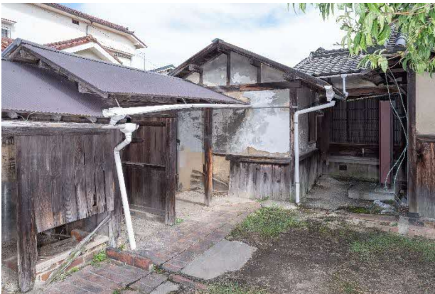
18 修理前 納屋(米蔵北)・納屋(北東) 敷地側
