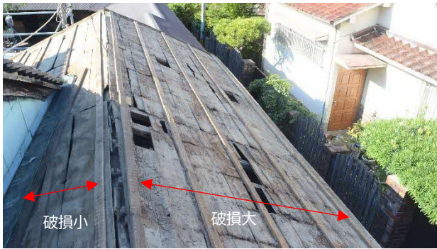
42 納屋(米蔵北) 屋根解体中 納屋(米蔵北)の屋根は、東流れ(写真右手)の方が大きく破損した状態にありました。しかし、板を留めている釘は、東流れの方が新しいタイプのものが用いられていました。
