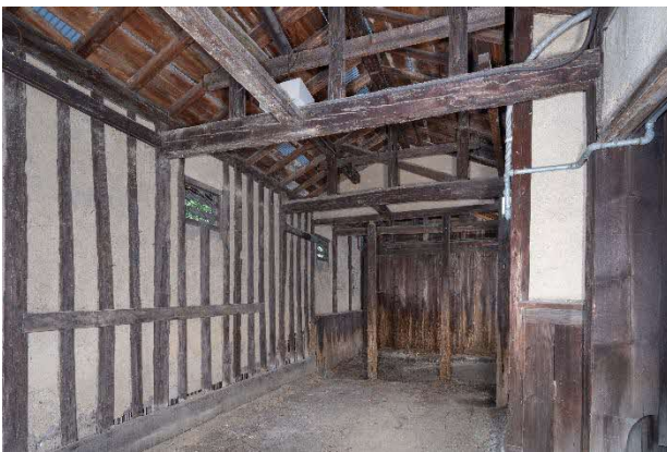
20 修理前 納屋(米蔵北) 内部
