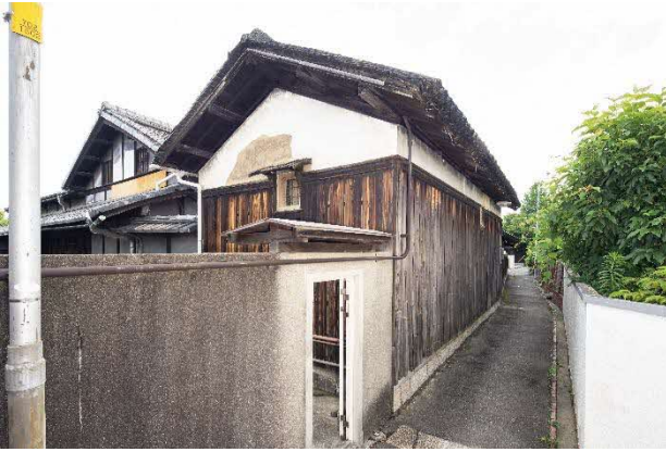
16 修理前 米蔵南面・東面
