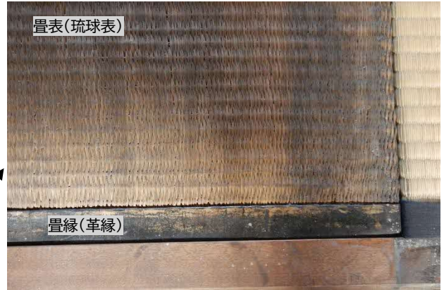
57 主屋 居間の畳 見つかった畳の畳表(たたみおもて)は琉球表と呼ばれる、やや丈夫なタイプのものでした。また畳縁(たたみべり)は革製で、今ではかなり珍しい仕様ですが、当時は、耐久性が求められる場所に、それなりに用いられていたようです。
