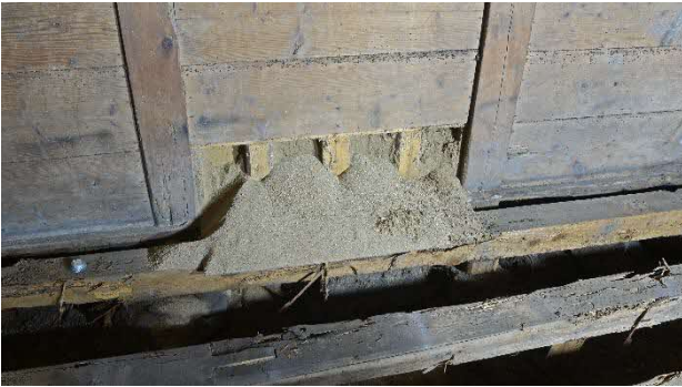
49 米蔵 壁板解体 米蔵の壁板を取り外したところ、中に砂が詰められていることがわかりました。防犯のためと思われます。
