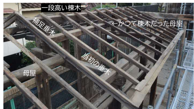
47 納屋(北東) 屋根解体中 西流れ南端 納屋(北東)の屋根のうち、南端の一角だけは形式が異なっていました。母屋の位置で当初の垂木がすべて途切れており、そこから棟木までの間の垂木は、後に補足された材になっていました。母屋や棟木の位置、高さもほかの場所とは異なっていました。また痕跡から見て、この一角の母屋は、かつては棟木であったと考えられます。
