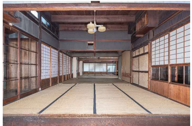
9 修理前 主屋内部 上り口から室内を見る
