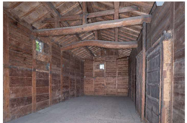
17 修理前 米蔵内部
