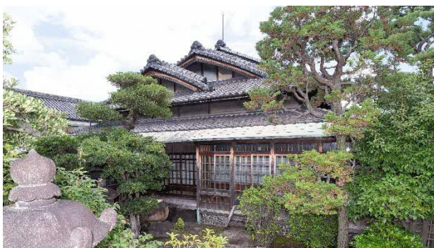
6 修理前 主屋西面(居住部)
