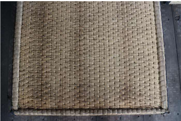
58 主屋 座敷の畳 座敷などの畳の畳裏(たたみうら)は手縫いの丹波裏が用いられており、かなり上等な仕様でした。また畳床も手縫いでした。
