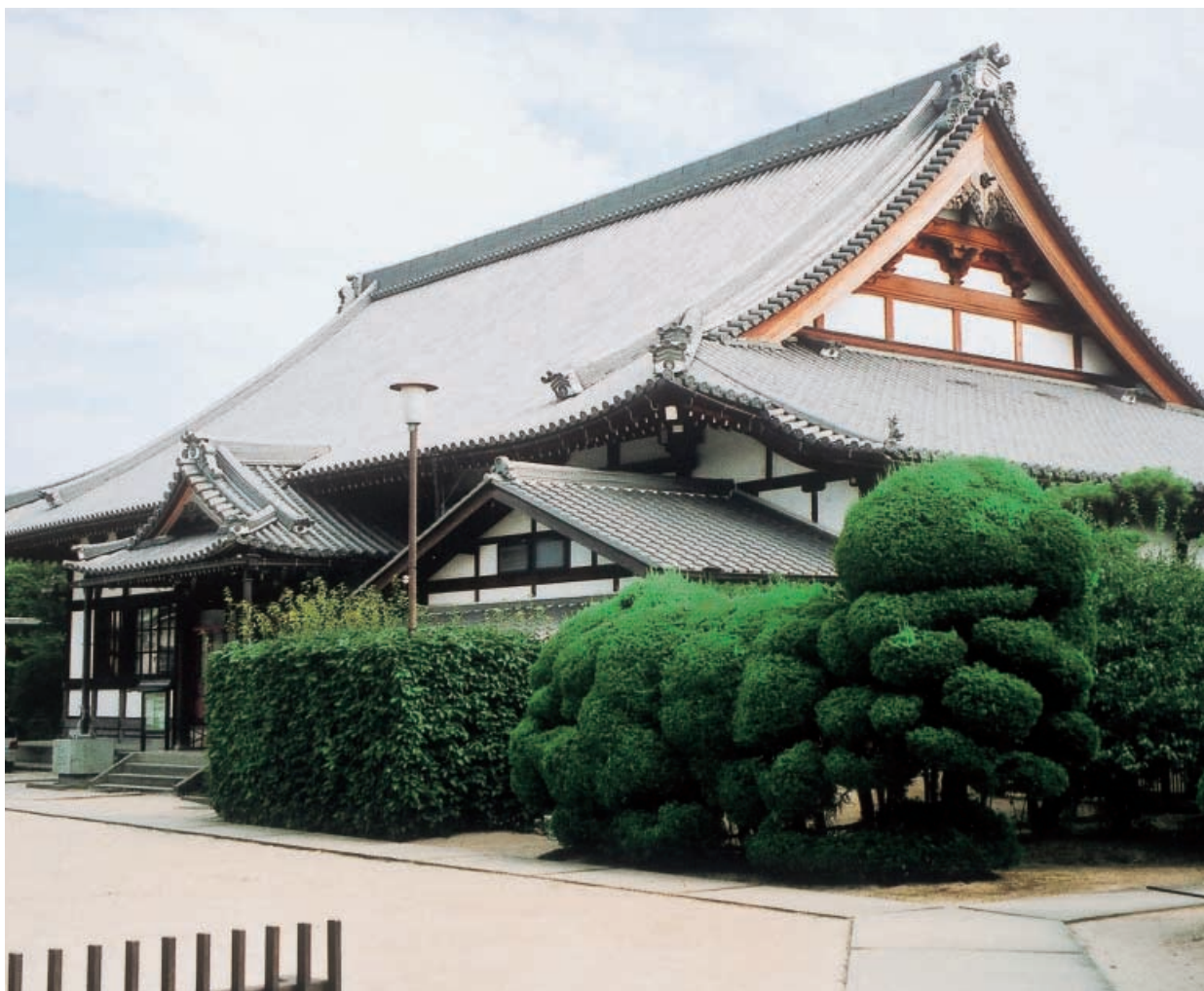
▲千里寺本堂（北西から）
