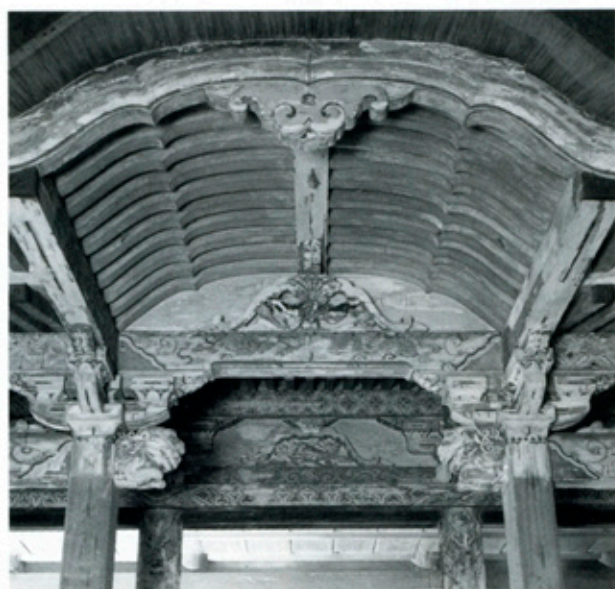
▲本殿の庇の中央部分
