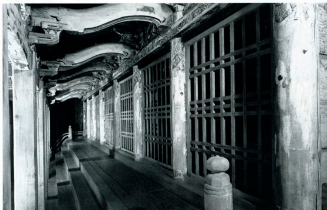
▲本殿の庇を横からみた状況
