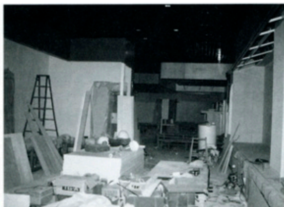
▲工事が進む第1展示室
