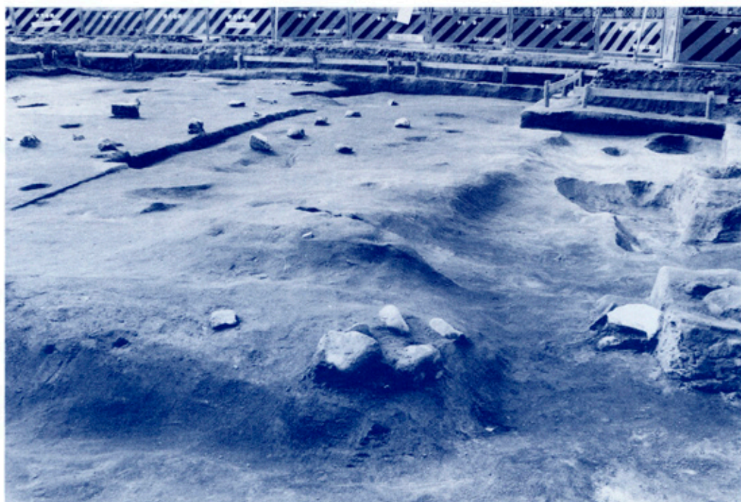
▲検出された護国寺創建時の基壇(北東から)
