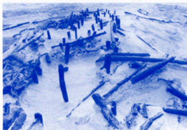
▲堤防の用材としては、大半は松が用いられています
