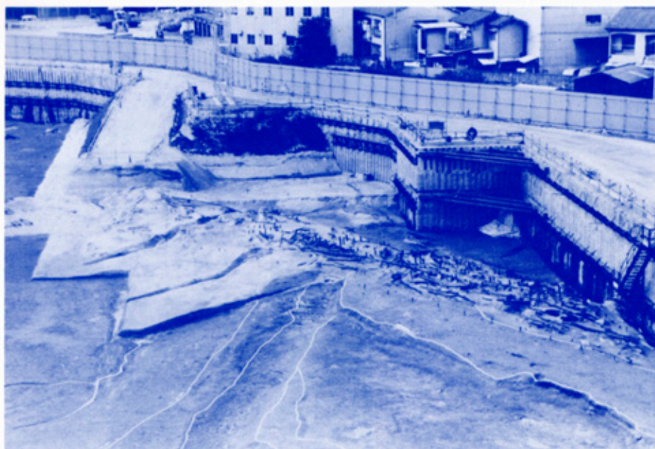
◀平安時代の堤防は延長60メートルにわたって調査されました。又、その一部は樹脂加工して、永久保存を図り、将来建設される資料館で公開展示する予定です。
