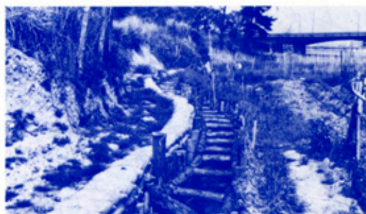
▲区画整理区域内の吉志部用水(開渠)の現状
