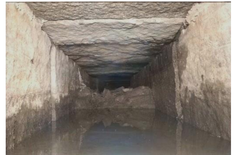
水路内部(西から)
