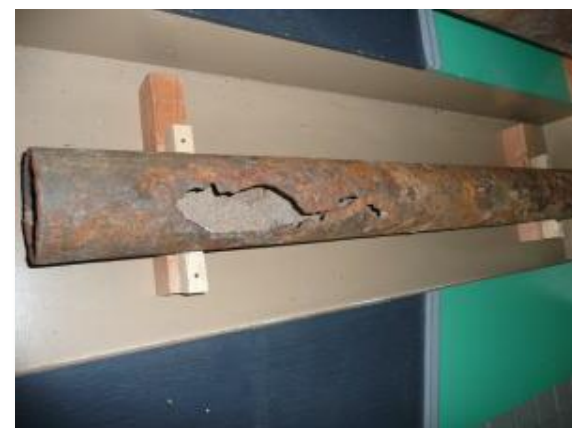
撤去した水道管
