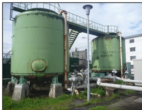
片山浄水所 急速ろ過機
