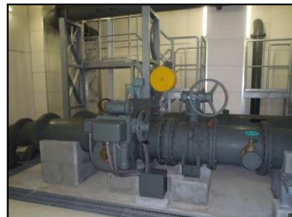
緊急遮断弁(千里山配水場)
