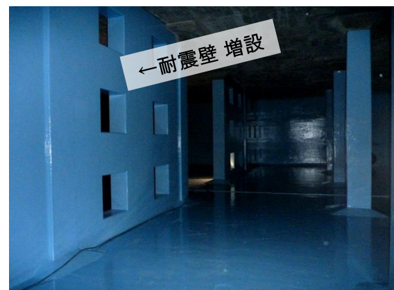
泉浄水所 第1配水池 内部
