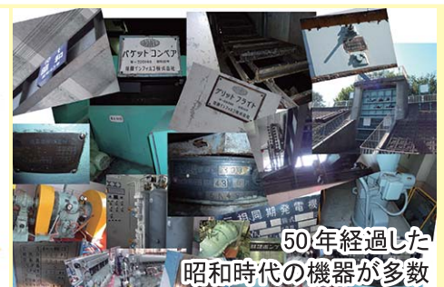
処理場・ポンプ場主要機器の老朽化の現状
