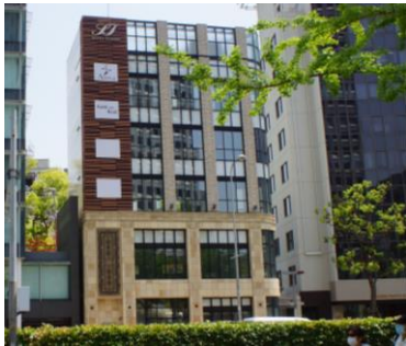
外壁のデザインに合わせ一列に配置し、盤面の地色 を白色に統一した事例
