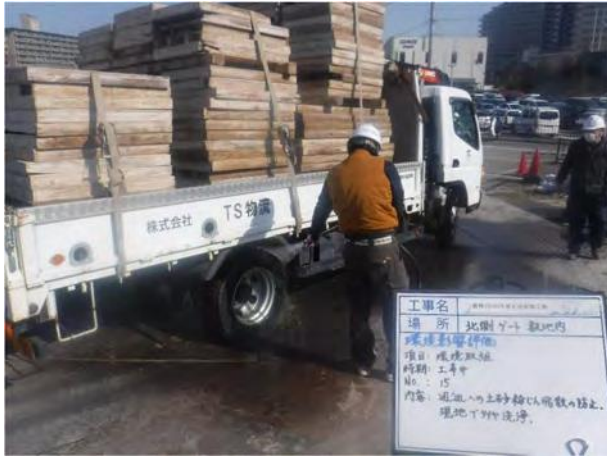
道路への土砂、粉塵飛散防止 タイヤ洗浄
