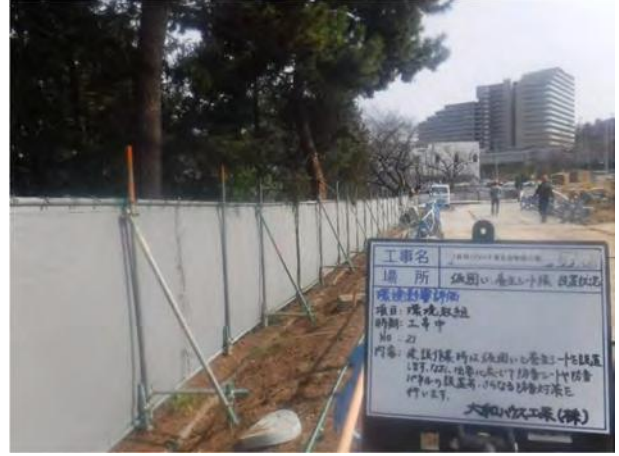
仮囲いシート設置
