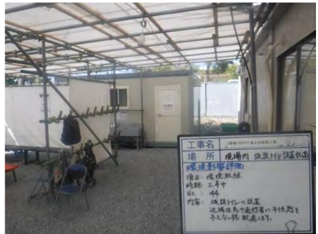
仮設トイレ設置
