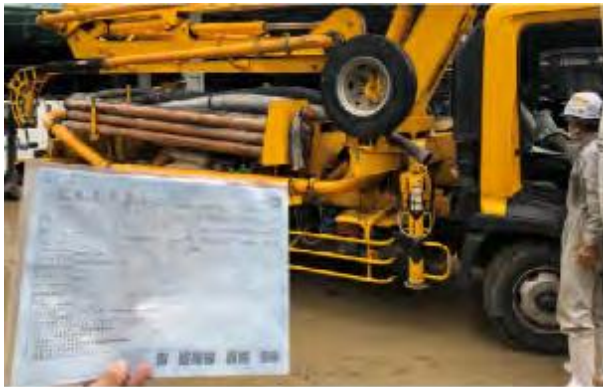
コンクリートポンプ車
