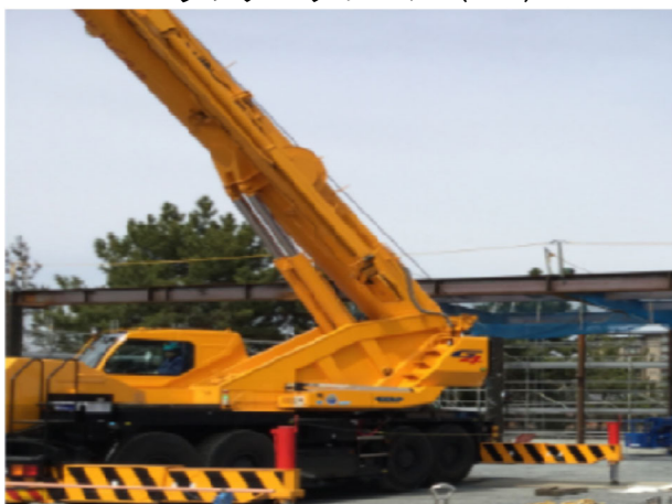
ラフタークレーン (70t)
