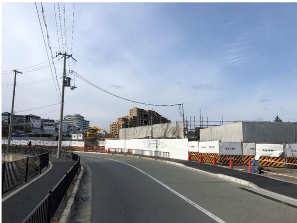
仮囲い設置 養生シート、フラットパネル、 フェンスバリケード+シート
