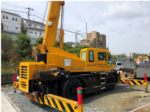
ラフタークレーン (25t)
